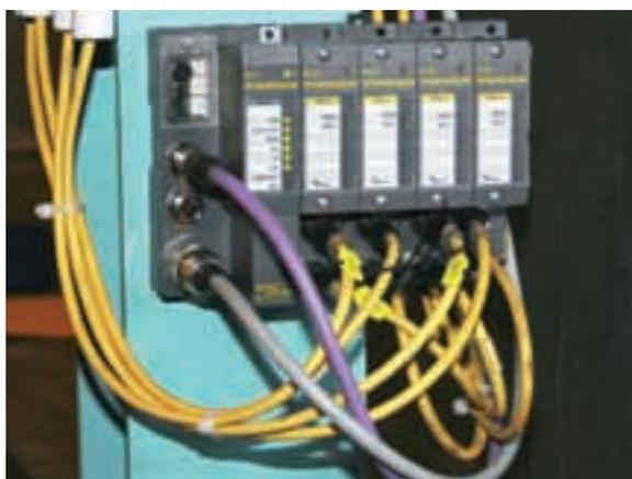
**Über das I/O-System BL67 mit Profibus-Gateway werden die RFID-Module eingebunden**
