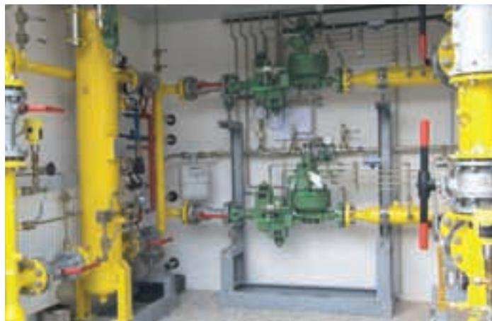
**Temperaturen, Drücke und weitere Messsignale werden erfasst und per Fernwartung an die Leitwarte übertragen**
