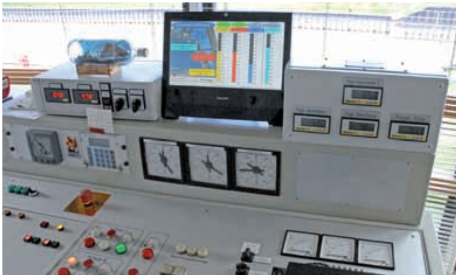
Auf einen Blick: Die Webvisualisierung im zentralen Steuerstand gibt jederzeit Auskunft über die Pegelstände in Ems, Schleuse und den beiden Hafenbecken
