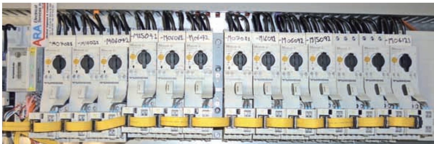
Im Handumdrehen installiert sind die Motorstarter, die über ein BL20-DeviceNet-Gateway in die Anlage eingebunden werden
