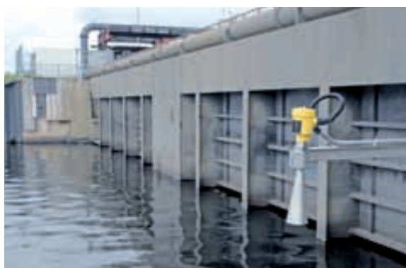
Die Wellen des Radarsensors werden vom Wasser reflektiert, die Laufzeit definiert den Pegel
