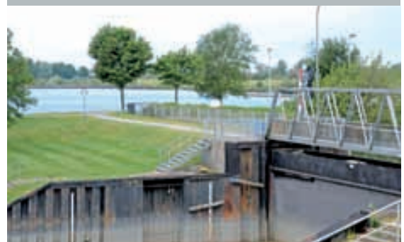
Im Papenburger See- und Binnenhafen sorgt Turcks DX70 für die effiziente drahtlose Übertragung der Pegelstände an den zentralen Steuerstand. Seite 32
