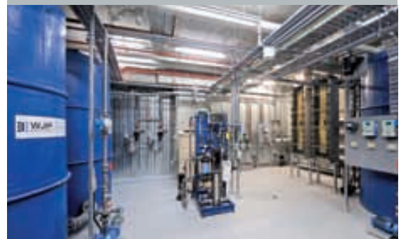
In Australien nutzt WJP Solutions für seine modularen Abwasseranlagen die robuste Anschlussstechnik und das BL20-Felddbusystem von Turck. Seite 36
