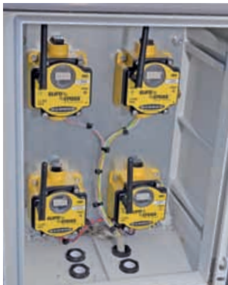
Auf dem Dach des Steuerstands sind die vier Funkempfänger installiert
