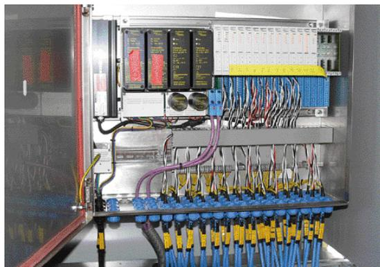
Startbereit: Die voll ausgebaute excom-Station mit redundanter 230V-Versorgung und LWL-Ankopplung ist bereit für das Hochfahren der Anlage
