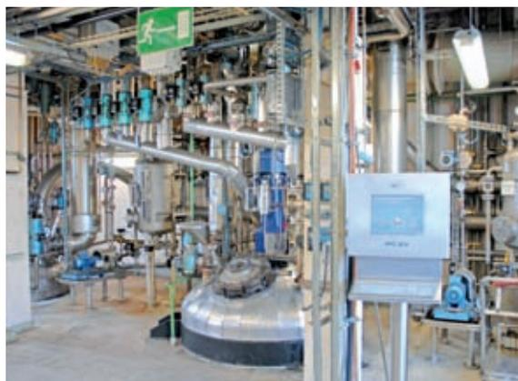
**In den Reaktorstraßen bei Elantas fallen zahlreiche analoge und binäre Messsignale an, die im nebenstehenden Schaltraum über Interfacekarten bzw. Turcks excom Remote-I/O an die Steuerung geleitet werden**
