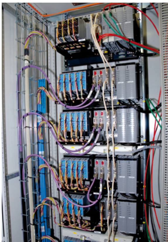
Die redundante Profibus-Anbindung des Leitsystems Yokogawa Centum VP erhöht die Verfügbarkeit
