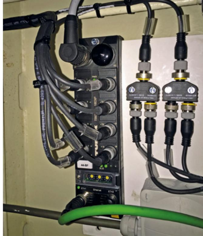
Schaltkästen und andere Schutzeinrichtungen sind mit Turcks robusten Block-I/O-Lösungen in IP69K nicht mehr erforderlich
