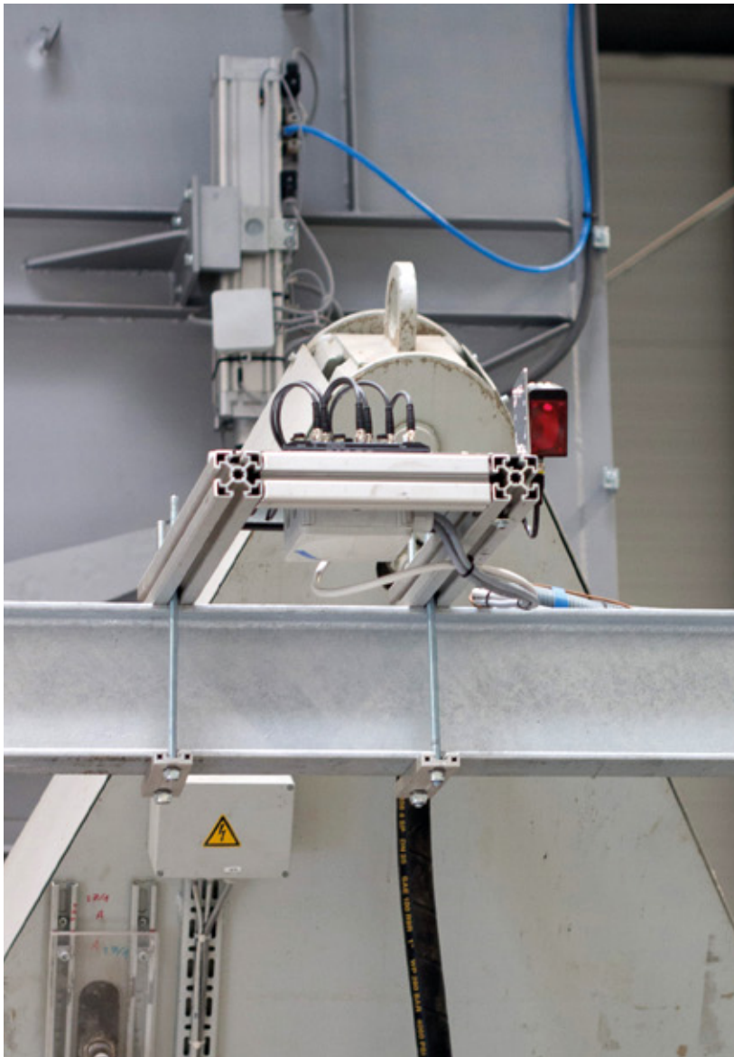
Der Lasersensor Banner LTF12 überwacht den Fortschritt der Papierballen und übermittelt beim Überschreiten des Grenzwerts ein Signal an das TBEN-S-Modul
