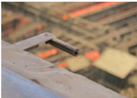
Referenzpunkte: Die RFID-Datenträger sind an definierten Positionen des Kranfahrwegs montiert
