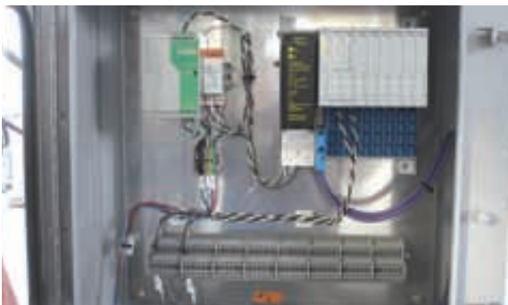
Status-LEDs auf Gateway und I/O-Modulen erlauben die einfache Funktions-Diagnose der excom-Station
