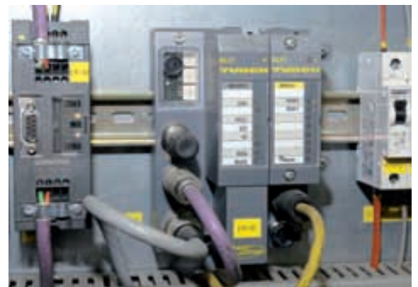
Über das Turck-I/O-System BL67 gelangen die Signale der Schreibleseköpfe an die Steuerung
