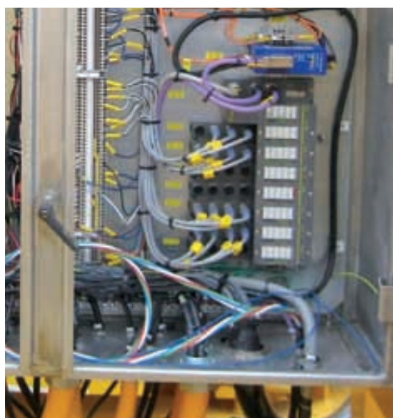
Turck's BL67-Remote-I/O-System steckt Stöße und Vibrationen der Portalkrane einfach weg
