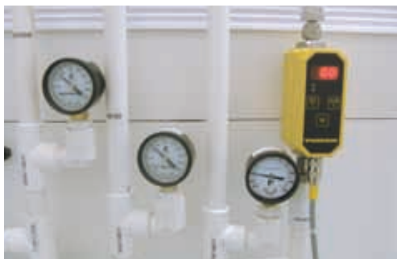
Turcks Durchflussmesser FCMI garantiert die Versorgung der Pflanzen mit Wasser und Nährstoffen
