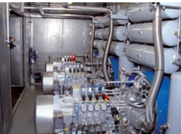
Bis zu vier Verdichter komprimieren das Erdgas in mehreren Stufen auf die benötigten 280 bar
