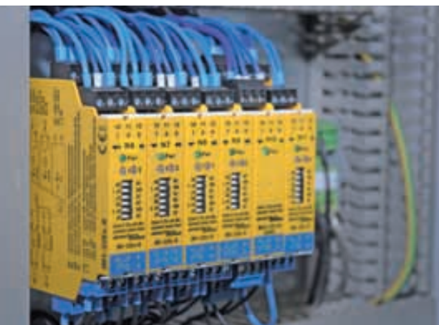
Eigensichere Trennschaltverstärker übertragen die Signale der Drucksensoren an die Steuerung
