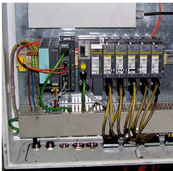
Das mit Codesys programmierte Gateway des BL ident-Systems kommuniziert mit dem Bedienrechner
